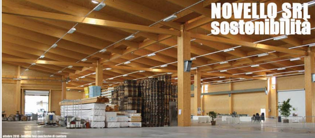
ottobre 2010 - lavori: fasi conclusive di cantiere
