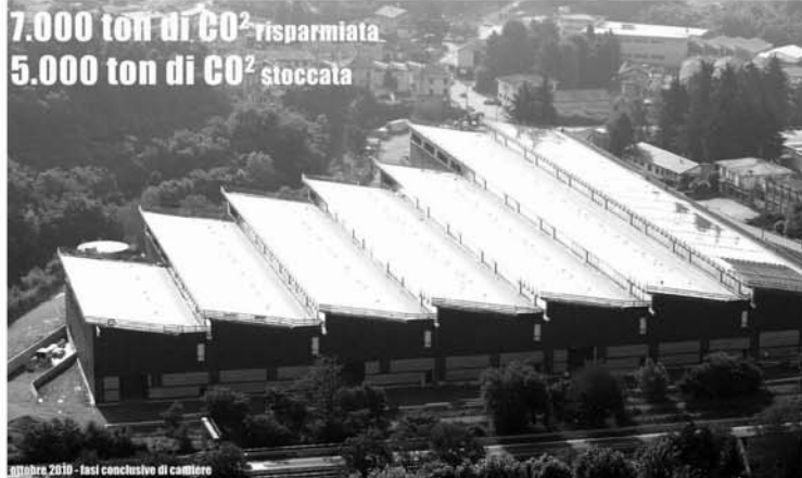
ottobre 2010 - fasi conclusive di cantiere
