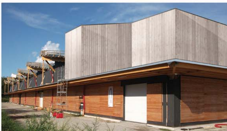
FIG. 09 10 cantiere fasi conclusive (sovrall - plastica di svolta in destra)
